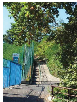
Escalier du stade J.Vallat
