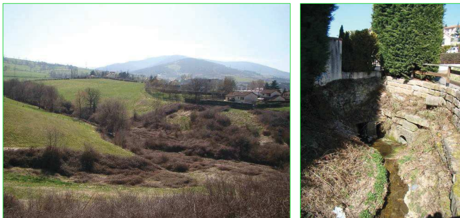
Le corridor du Coailleux, et la rupture de celui-ci au niveau des lotissements
