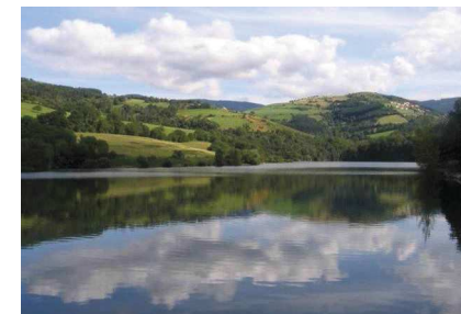
Le barrage de Soulage
